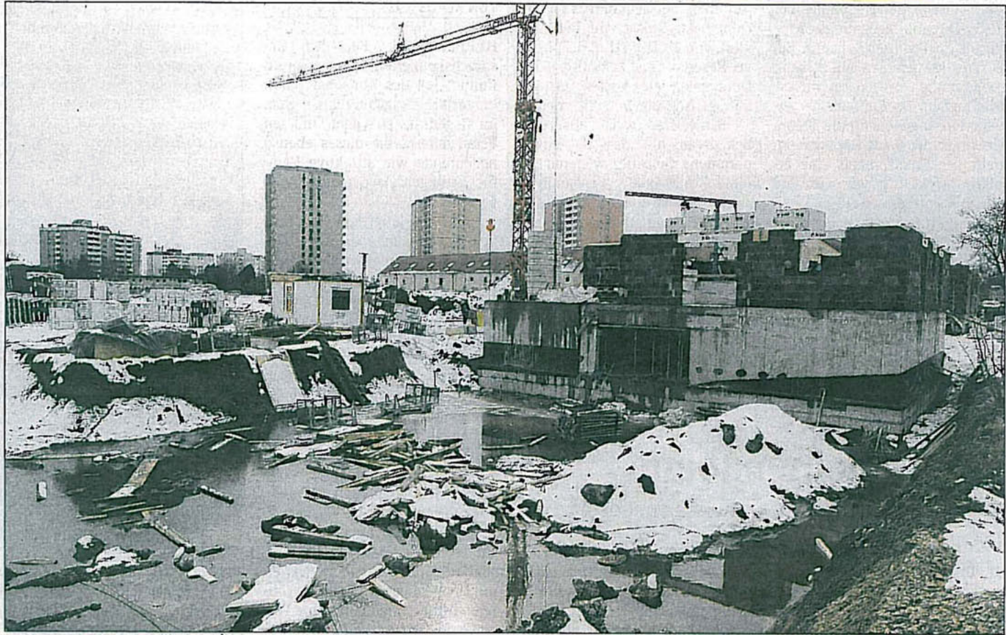
Noch Zukunftsmusik , aber schon bald Realität: Zwischen Willy-Brandt-Straße und Luise-Otto-Straße entstehen an der Mozartstraße in den nächsten Monaten peu-à-peu fünf Mehrfamilienhäuser und 44 Doppelhaushälften.
